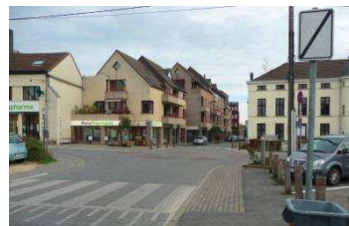
Photo 3 - avenue du Douaire
